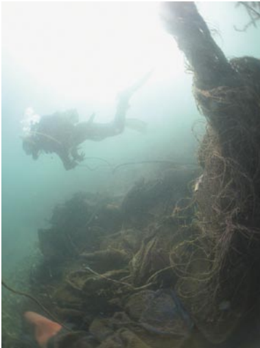
鬼沢漁港での瓦礫撤去
