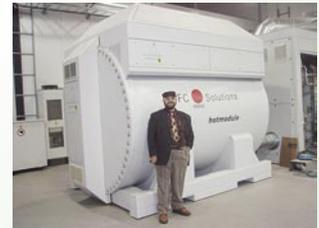
写真はドイツにあるガス発電施設の巨大な高温動作型燃料電池です(体の大きな筆者が小さく見えます!)。ここでは、バイオマスからのメタン発酵ガスが発電に利用されています。世界的にも珍しいバイオガスによる燃料電池発電の実用化が非常に早いスピードで行われているのに驚きました。その背景には、環境負荷が少ない技術で生成した電力を、最大で通常価格の約3倍という高値で売電できるという実情があります。大きなインセンティブにより、小さな組織を伸ばす政策システムの有効性を再認識できました。
